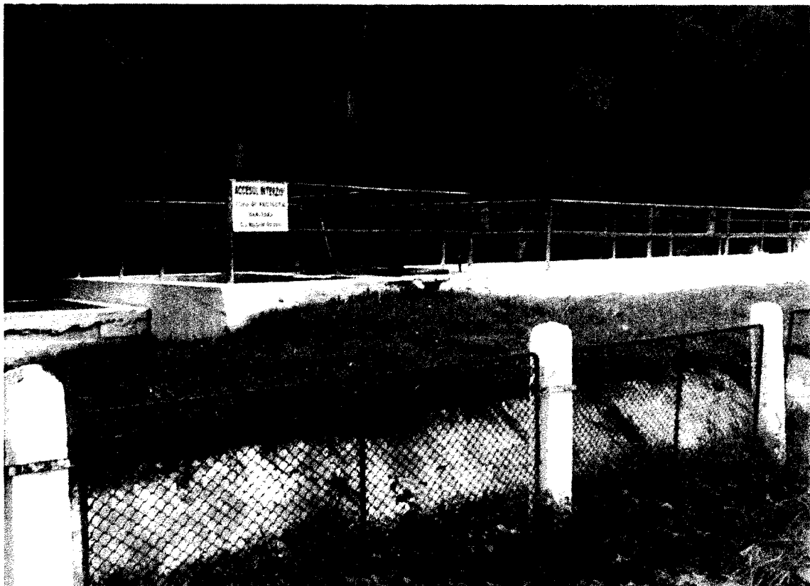
Gardul de protecție zona sanitară pentru uzina de apa este deteriorat și are o înalțime foarte mică.
